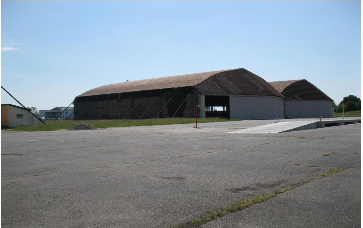
De droite à gauche vue du bâtiment 163 et du petit bâtiment 164 (toilettes)
