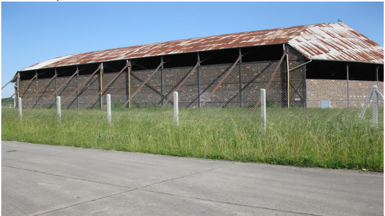
Vue sur le côté du bâtiment 163
