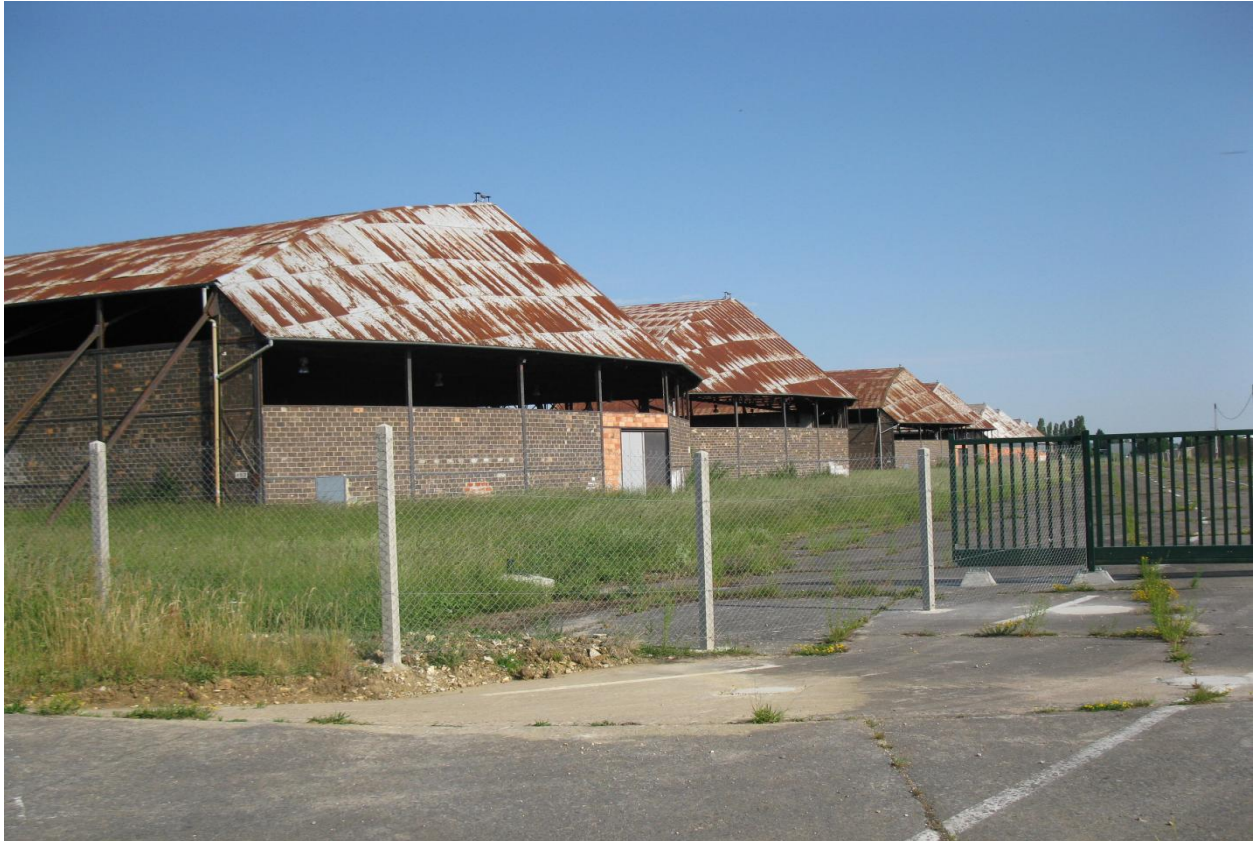
Vue de l'arrière des bâtiments 163 (premier plan) et 165
